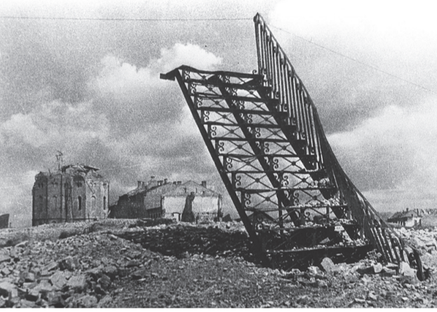
На снимке: район бывшего Могилевского рынка (начало улицы Калинина). Взорванная водонапорная башня («Лестница в небо»), июнь 1944 года. Фото предоставлено В. Борисенковым.
